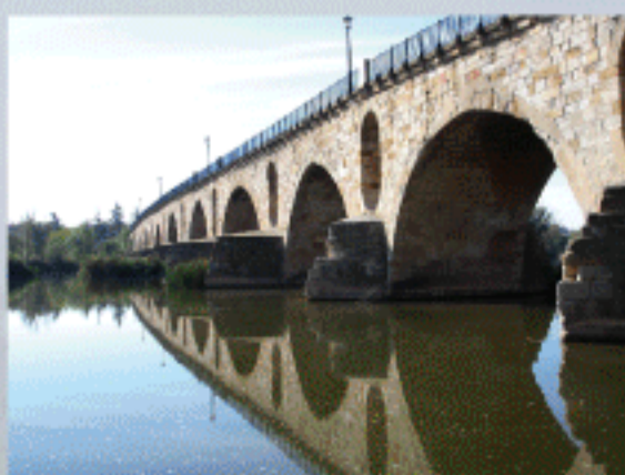
Puente de Piedra
