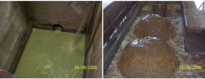
Desengrasado y desarenado: a través de diferentes sistemas de aireación se separan y clasifican las arenas y los flotantes del agua, para ser trasladados al CTR
